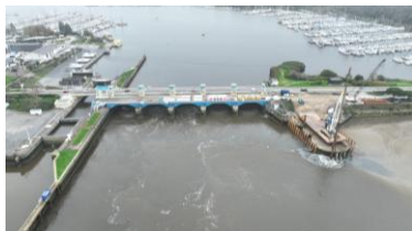
Travaux sur le barrage
